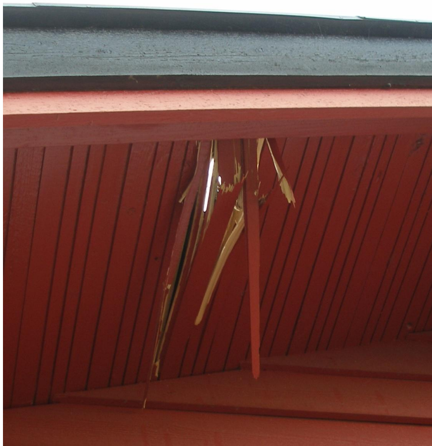
Fot.1. Zniszczenia dachu spowodowane upadkiem meteorytu w Rodeløkka (fot. M.Stolarzek)
